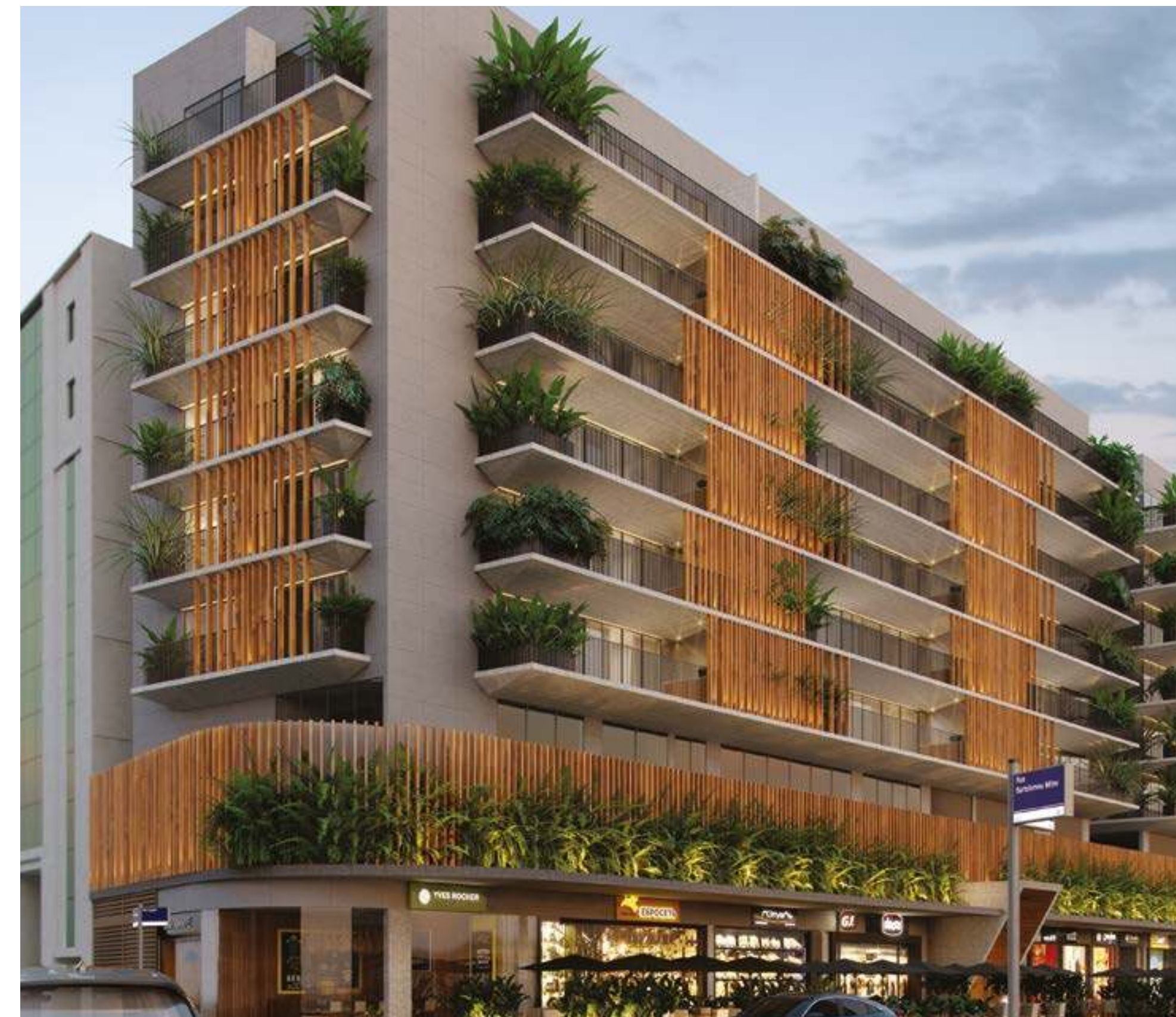
FACHADA - AV. BARTOLOMEU MITRE
