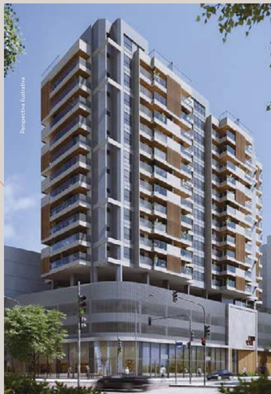
Maison Laranjeiras Rua das Laranjeiras, 139 Laranjeiras
