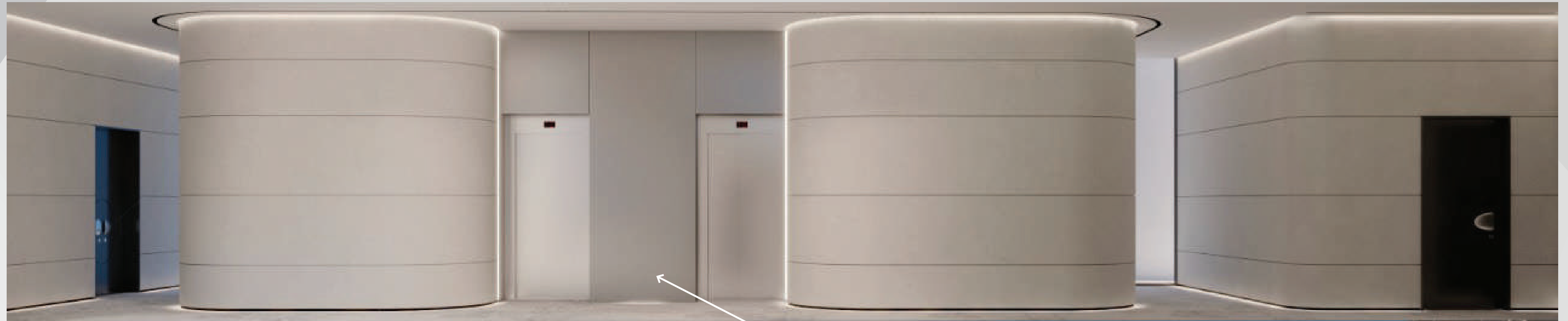
HALL DOS ELEVADORES - PAVIMENTO LAZER
