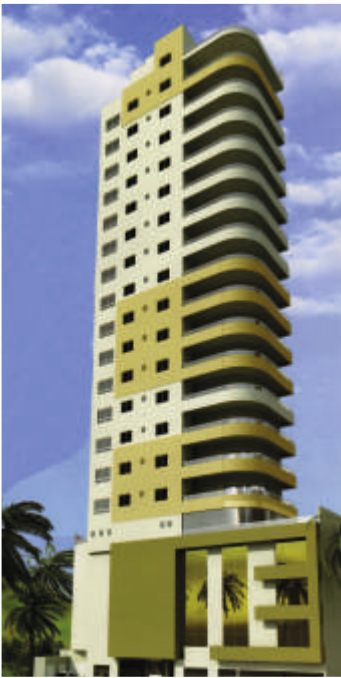
Farol de Arvoredo Obra Entregue 2009
