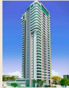
Torre del Parc
