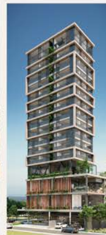
Voll29 Design Mix Manaira em construção
