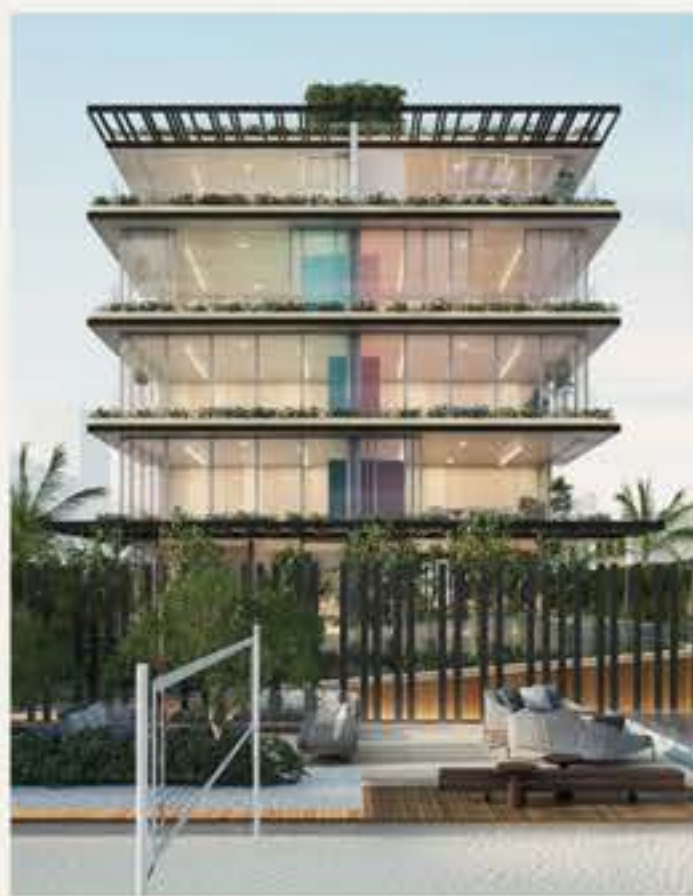
Solarium Beach Residence Camboinha em construção
