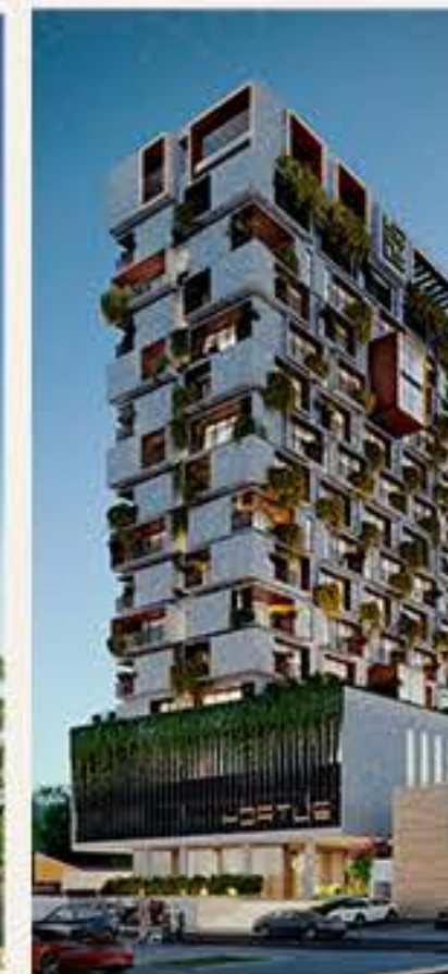
Hortus Manaira em construção
