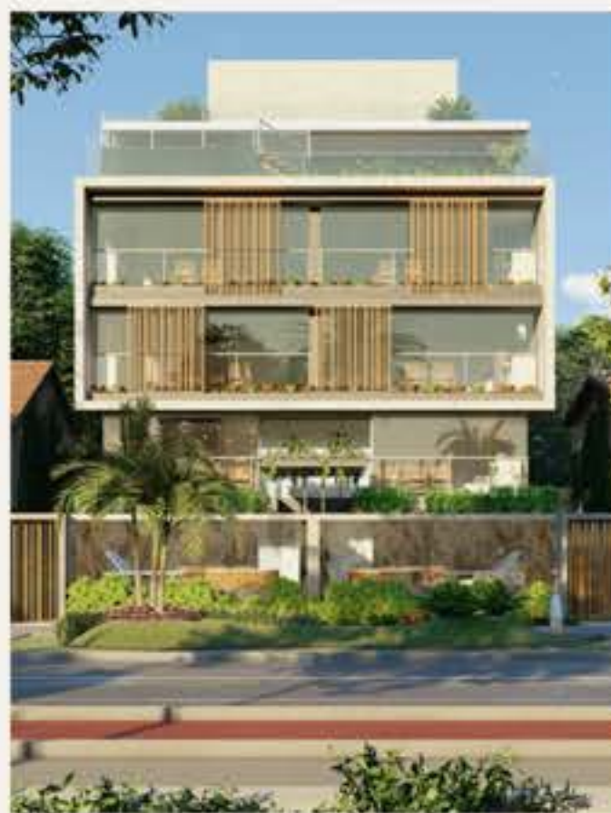
Oré Residence Cabo Branco em construção
