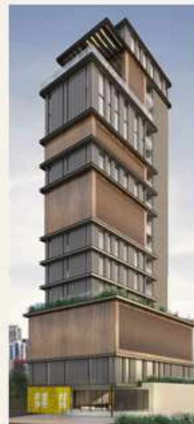
Neue Hotel Manaira em construção
