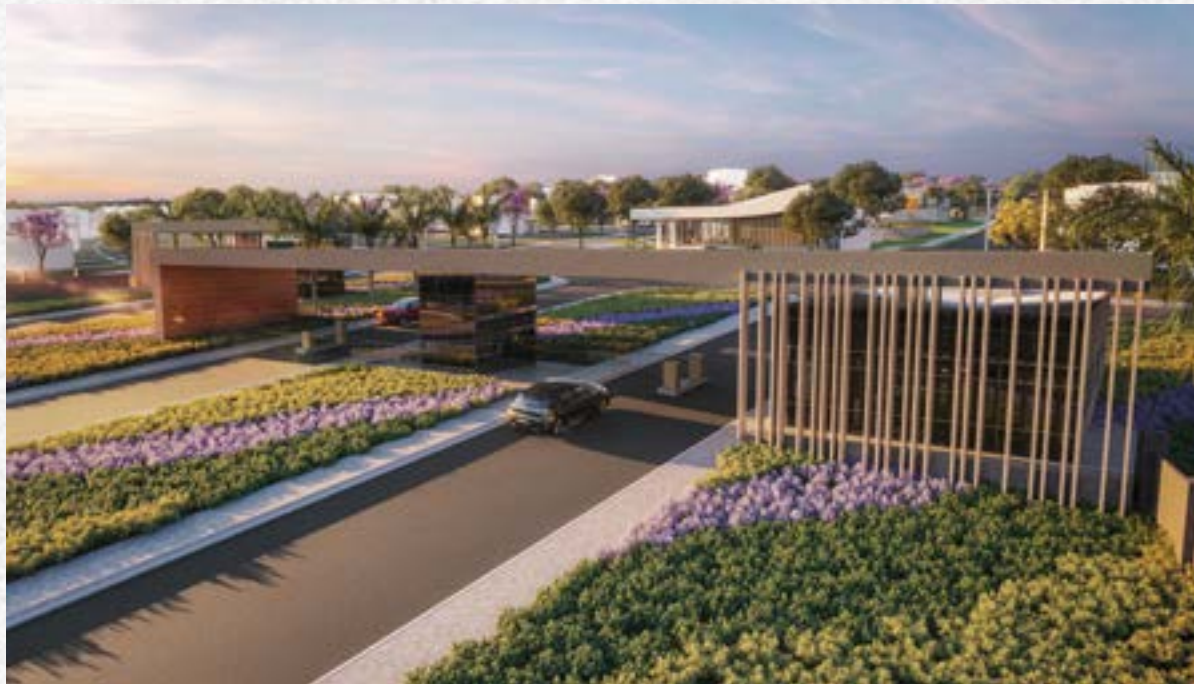
CONDOMÍNIO HORIZONTAL ENTRE RIOS
