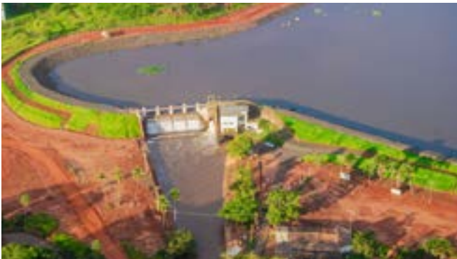
CGH CORUIÃO - ARAGUAÍNA - TO REVITALIZAÇÃO DA BARRAGEM - ENEL/GREEN POWER
