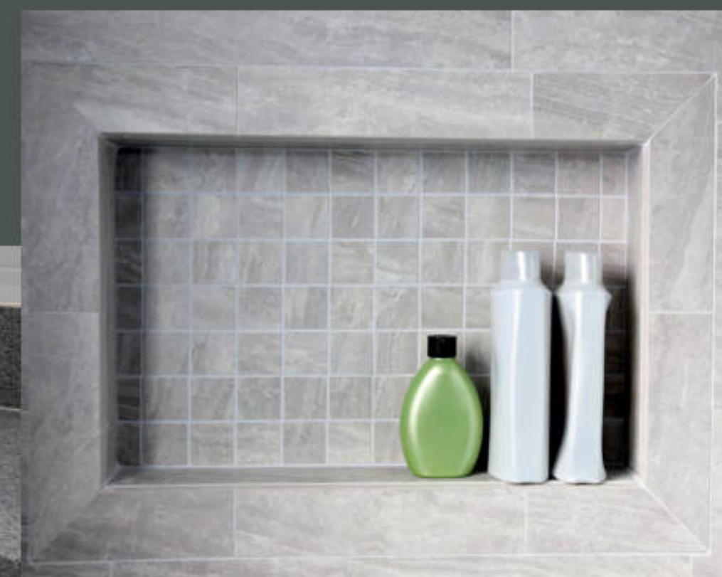
Nicho para o box do banheiro em porcelanato
