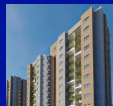
VARANDAS CONDOMÍNIO CLUBE ANÁPOLIS/GO LANÇADO EM 2022
