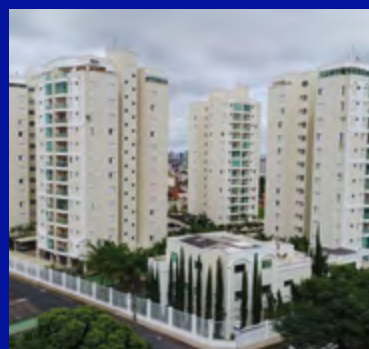
IMPERIAL RESIDENCE UBERLÂNDIA/MG LANÇADO EM 2008
