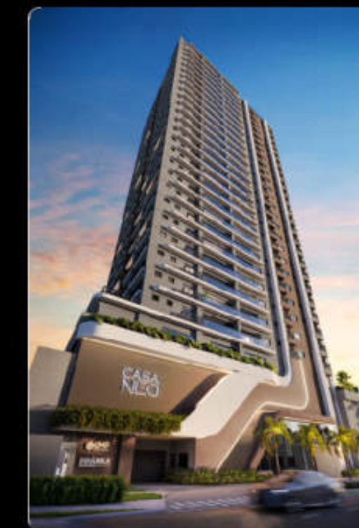
CASA NEO Em construção
