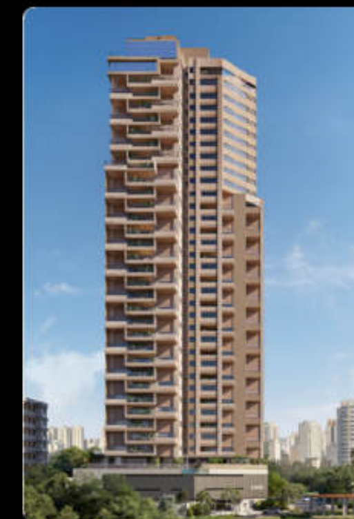
LODGE VACA BRAVA Em construção
