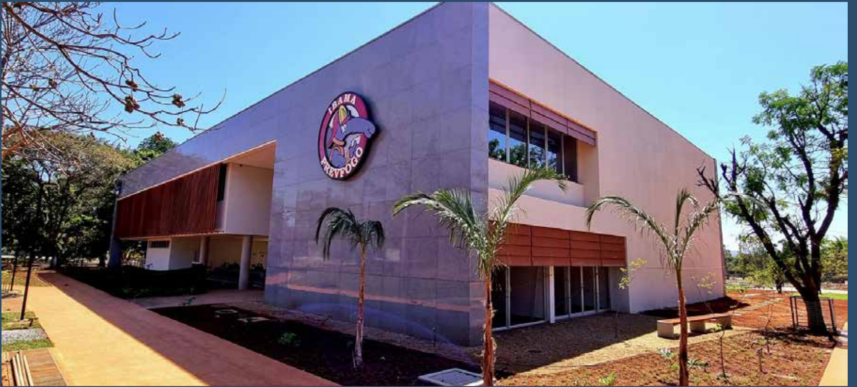
CONSTRUÇÃO PREDIO PREVFOGO IBAMA BRASÍLIA
