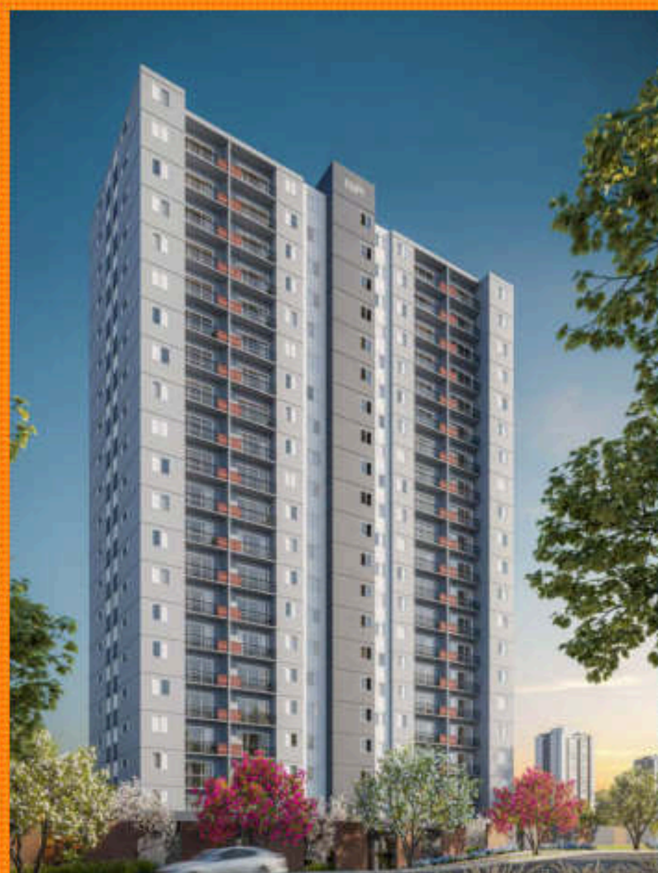
2024 NOW ALAMEDA DAS ÁGUAS OBRAS INICIADAS
