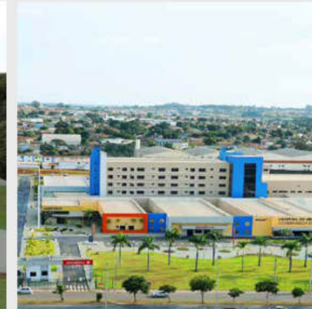
CONSTRUÇÃO | HUGOL (GO)
