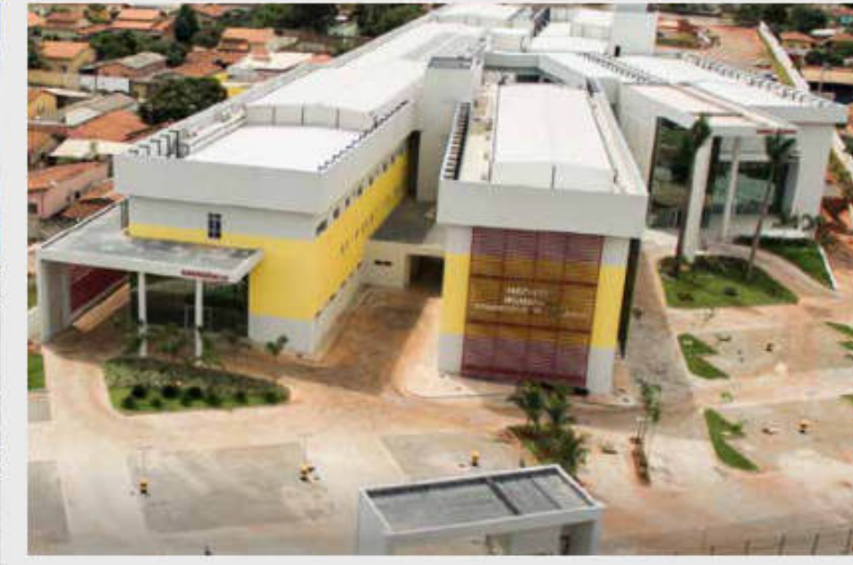
CONSTRUÇÃO | HOSPITAL MUNICIPAL DE APARECIDA DE GOIÂNIA.(GO)
