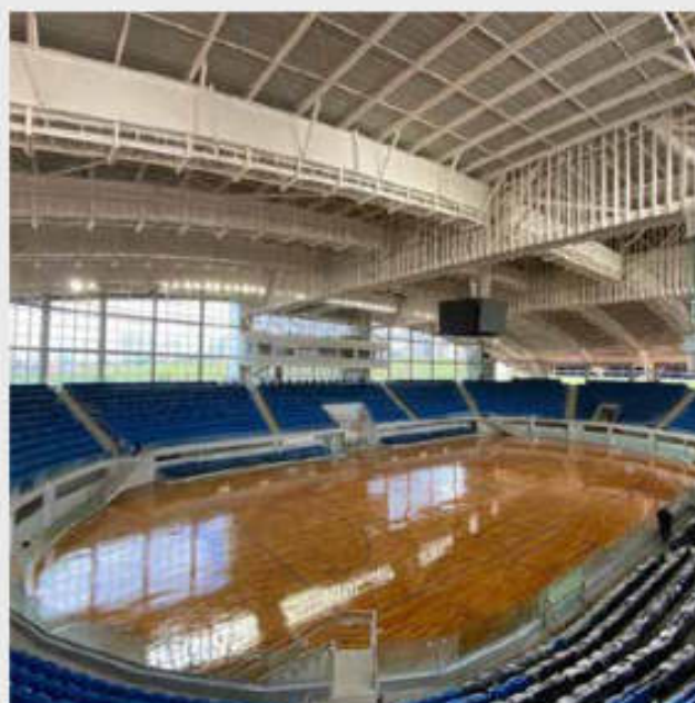
CONSTRUÇÃO | ARENA MUNICIPAL DE ESPORTES (SP)
