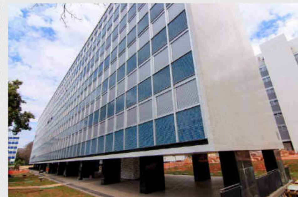
RESTAURAÇÃO | BLOCOS RESIDENCIAIS DA CÂMARA DOS DEPUTADOS (DF)
