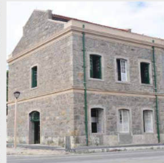
RESTAURAÇÃO | CENTRO CULTURA DA CAIXA (CE)
