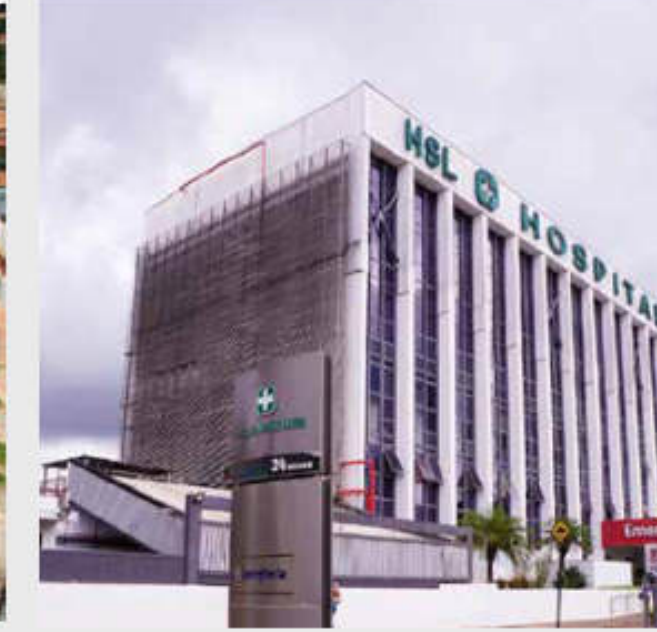
CONSTRUÇÃO | HOSPITAL SANTA LUZIA (DF)
