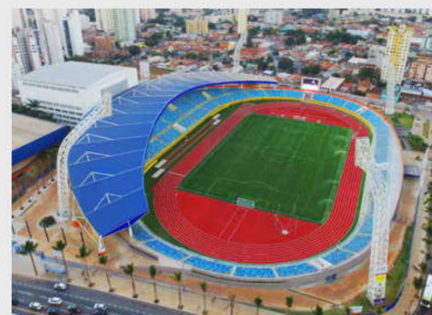
CONSTRUÇÃO | ESTÁDIO OLÍMPICO (GO)
