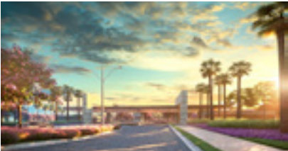
Portaria com câmeras Muro com cerca elétrica Ronda externa e interna
