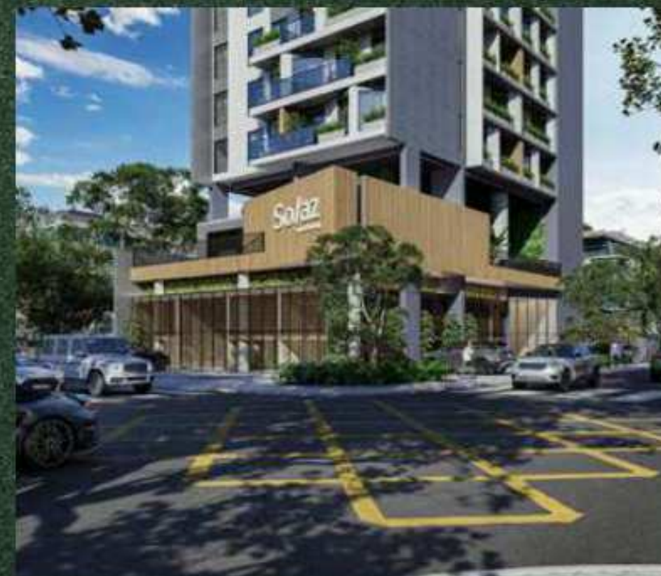
SOLAZ EM CONSTRUÇÃO 📍 JOÃO PESSOA
