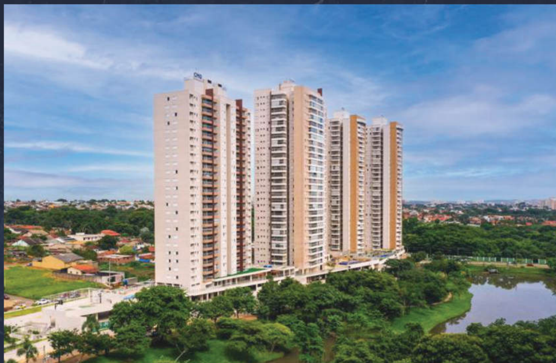
Varandas de Copacabana, Varandas de Ipanema e Varandas do Parque
