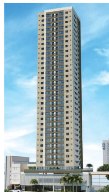
Rua S-4 LANÇAMENTO
