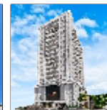
Trémont Floresta EM OBRAS
