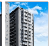
Rosa Branca Estreito EM OBRAS
