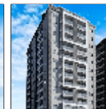
Orquídea Branca Estreito EM OBRAS
