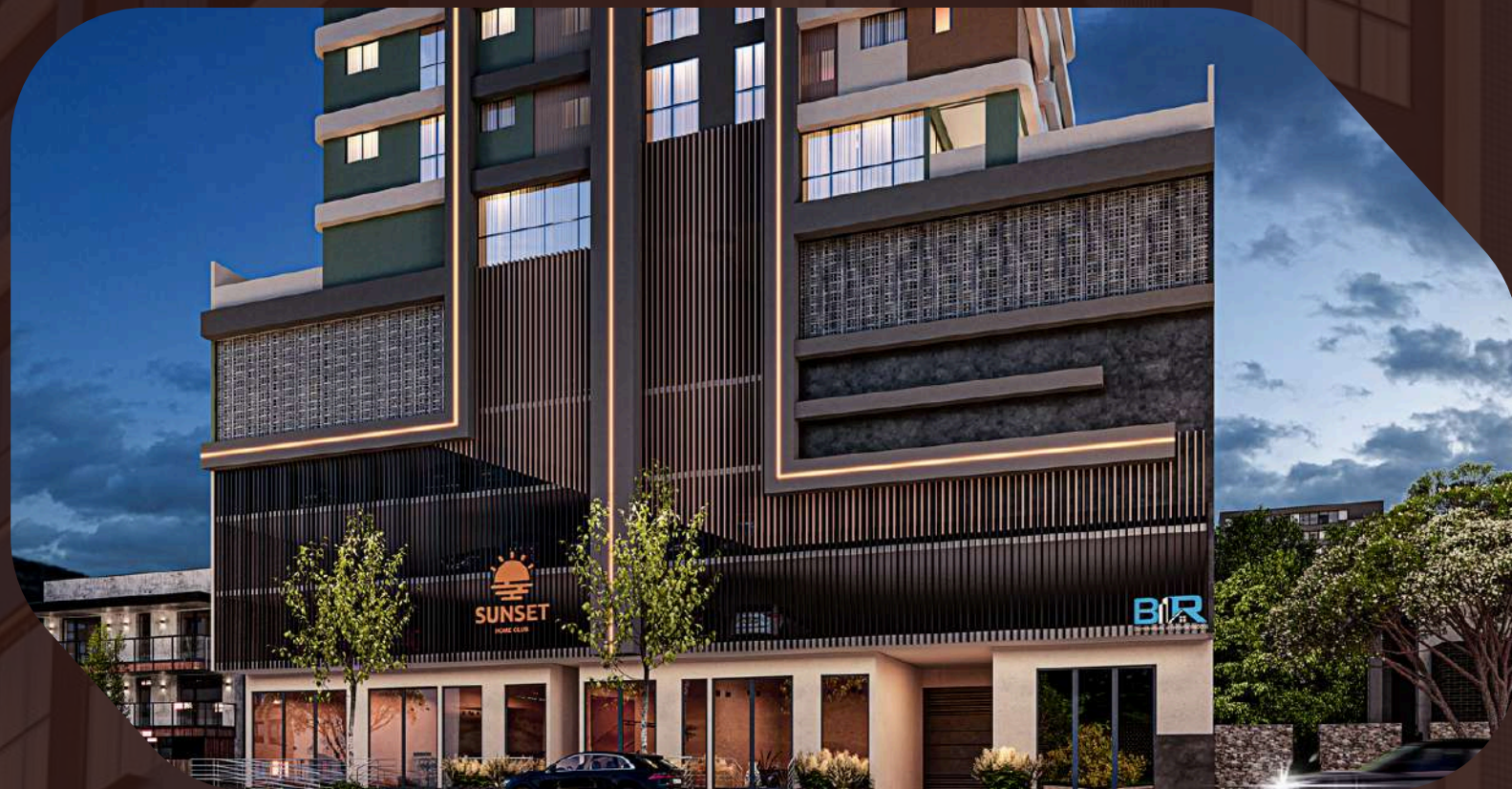
Fachada externa em Leds
